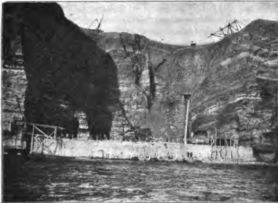
Fig. 4. Die Schutzmauer an der Westseite des Felsens während des Baues 1903.
